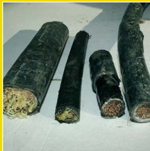
Kablovi ispunjeni uljem
