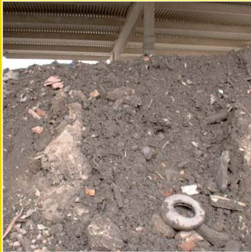
Tlo iskopano tijekom sanacije odlagališta
