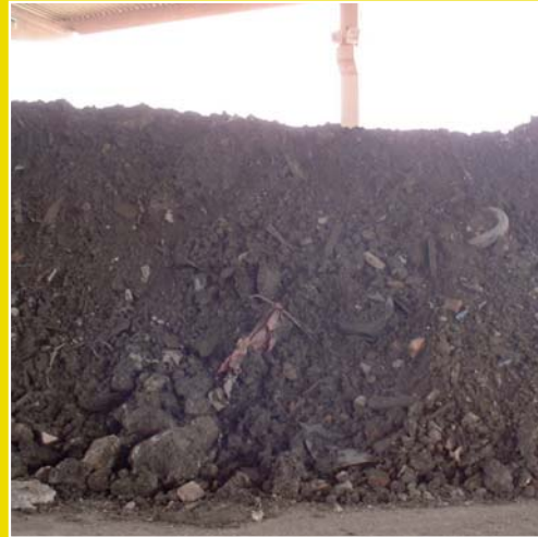
Tlo iskopano tijekom sanacije
